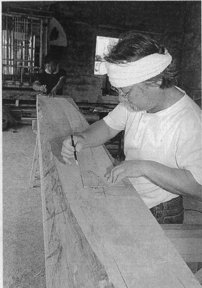
「隅木」の切り込み作業を行う棟りょうの西さん=11日、中休み近くの加工現場
